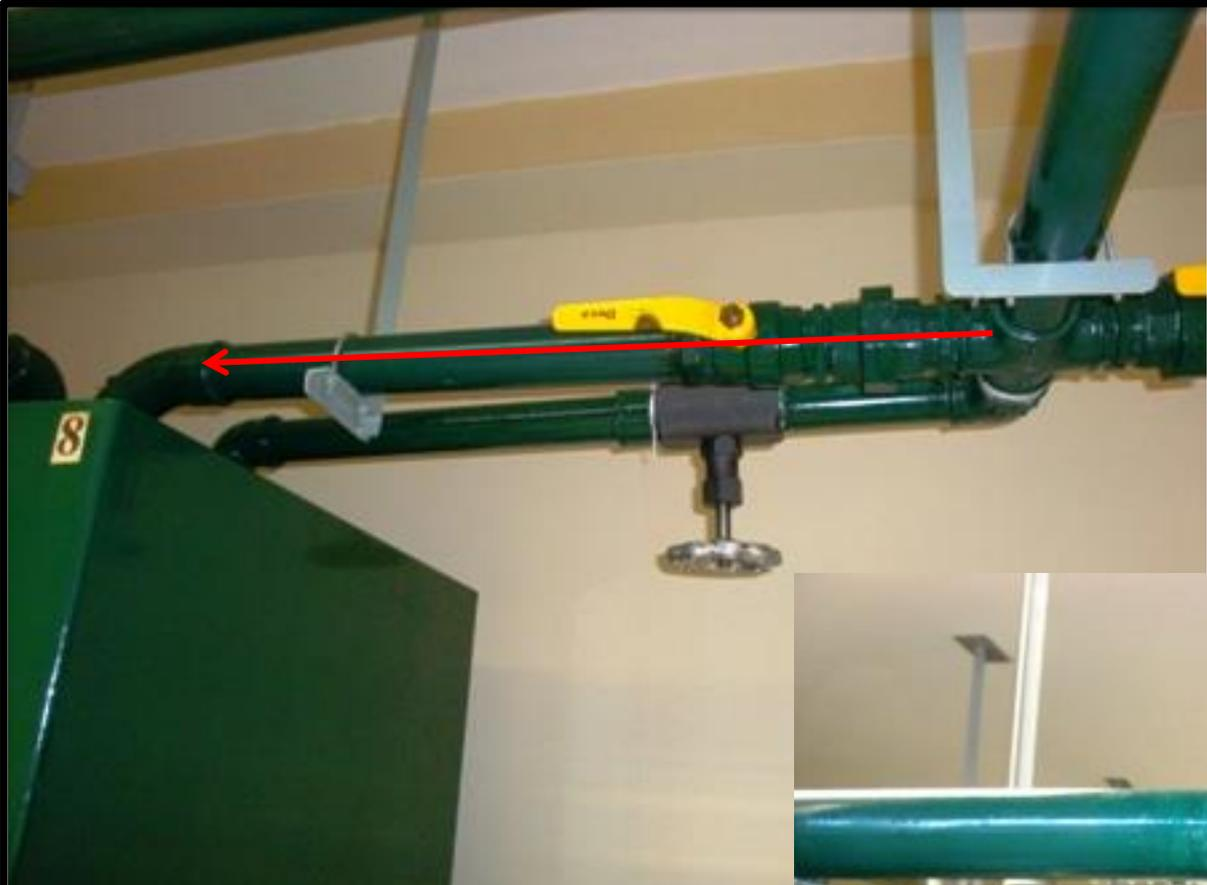
Detalhe do escoamento sem a válvula agulha
