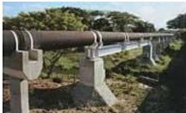
**Observação:** Para um  $D_N$  dado, o diâmetro externo de um tubo é idêntico, qualquer que seja a classe de espessura. Para tubos DN 100 até DN 300 classe K7 considere-se:  $e = 4,75 + 0,003 \text{ DN}$ , onde “e” é a espessura em mm da parede do tubo.
